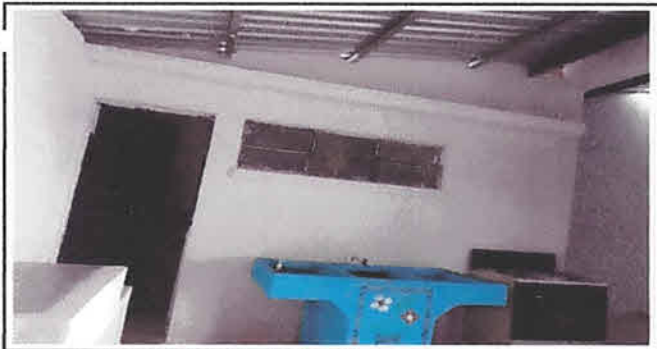
Foto 5: REPELLO LATERAL DE COCINA
